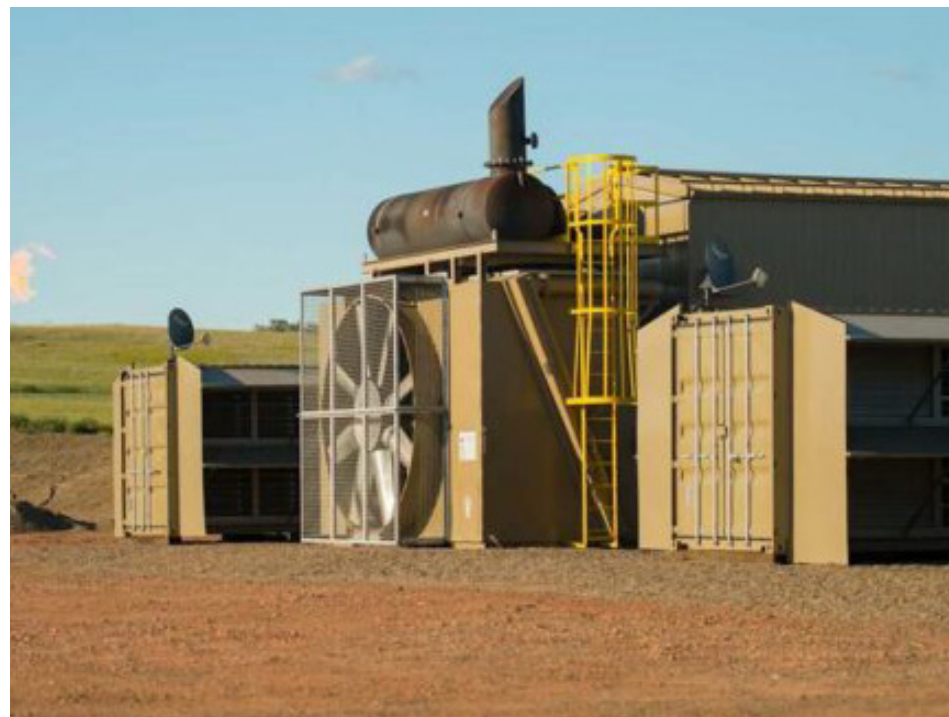
Figure 20 : C'est Crusoe Energy qui a été choisie pour faire le Gigadatecenter Stargate au Texas. Cette société de minage de bitcoin s'est fait connaître en exploitant le gaz torché sur des puits de pétrole pour alimenter ses calculs - Source : crusoe.ai
